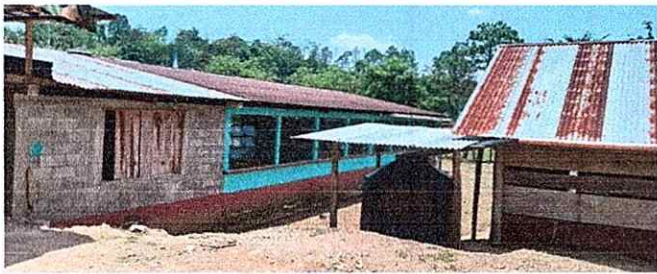
Foto 5: Sustitución de cubierta de lámina.
