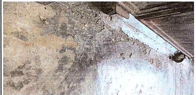
Foto 4: Sustitución de piso.
