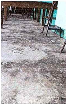
Foto 3: Sustitución de piso.
