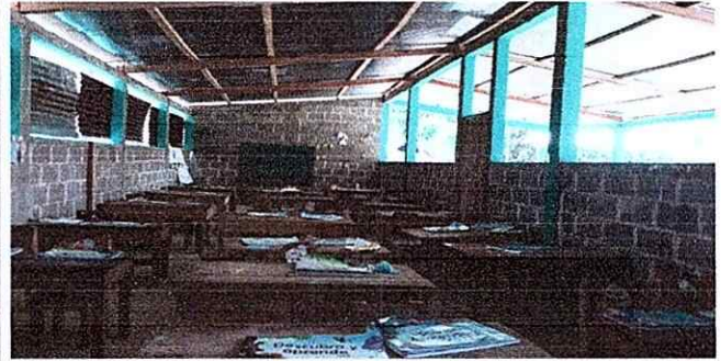
Foto 2: Sustitución de ventanas, piso y puerta.
