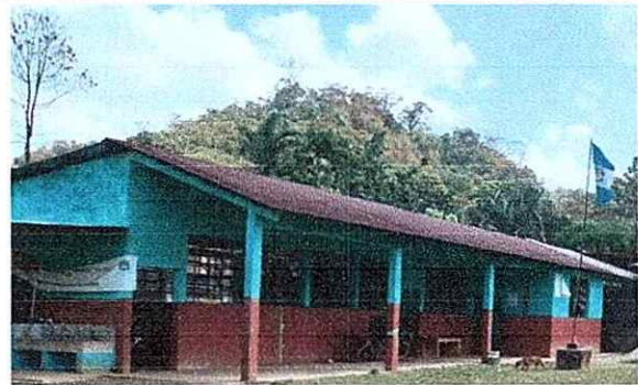
Foto 6: Sustitución cubierta de lámina.
